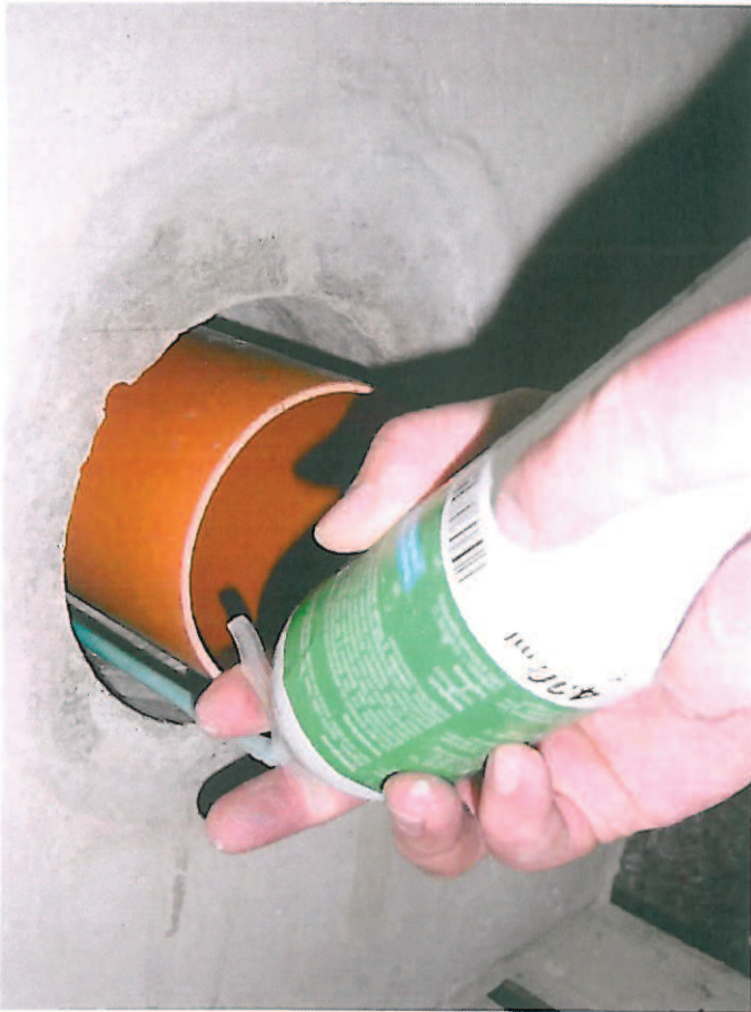
Bild 1: Herstellung des Widerlagers mit PUR-Schaum Würth PURLOGIC FAST von der Bauteilinnenseite
