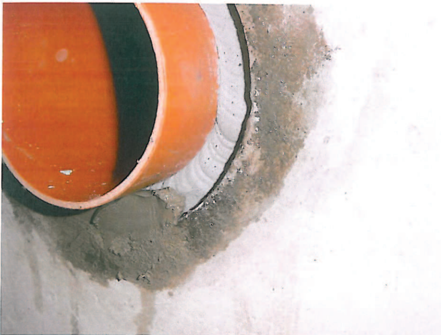
Bild 4: Raumseitiger Verschluss des Ringspalt mit Schnellzement Würth FIXZEMENT
