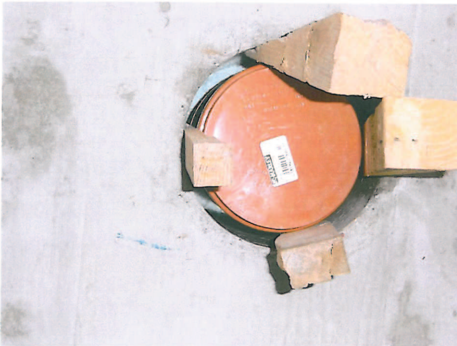
Bild 2: Rückseite des Probekörpers (Bauteilaußenseite) - Prüfungsbedingte Lagesicherung des Rohres mit Keilen während der Applikation und Aushärtung des PUR-Schaumes
