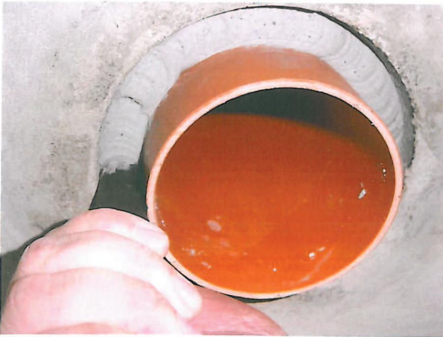
Bild 3: Fehlstellenfreie Applikation der Dichtmasse Würth RKD FLEX in den Ringspalt
