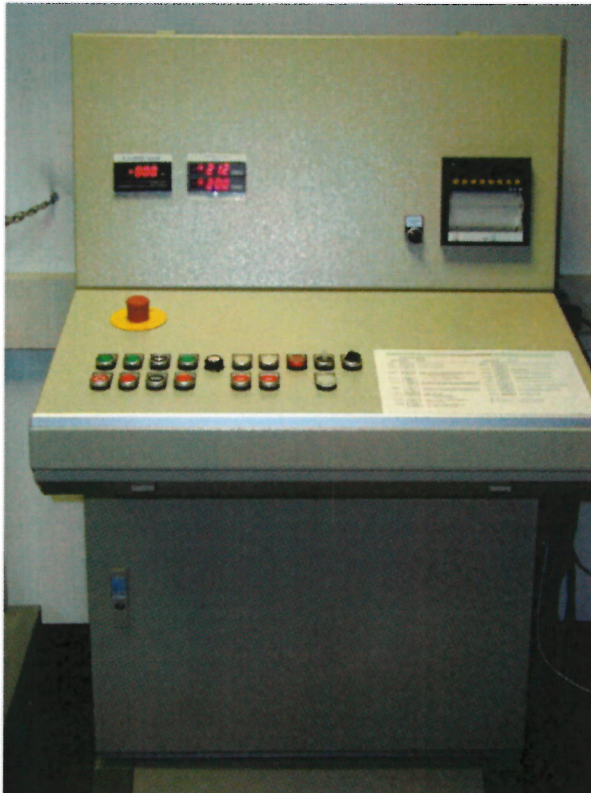
Bild 3a: Prüfstand-Steuerung (Drucksteuerung)
