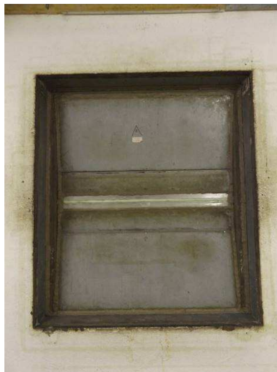
Bild 3 Fotos des eingebauten Elementes (erstellt vom ift Labor Bauakustik)
