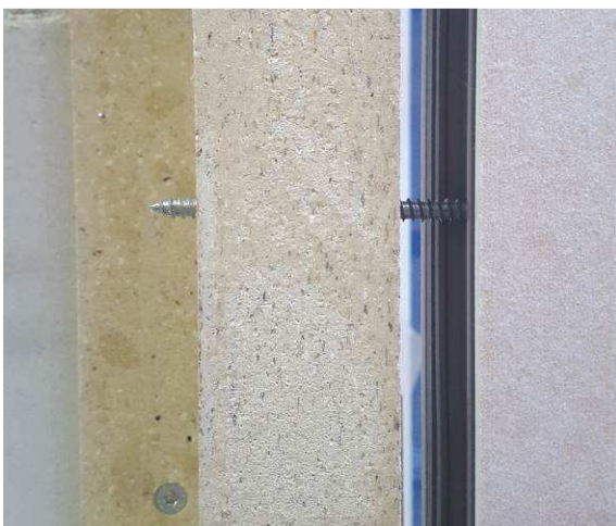
Bild 5 Durchschraubung der Zarge zur Fensterbefestigung
