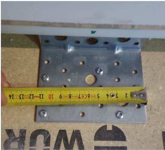
Bild 7 Befestigungswinkel unten
